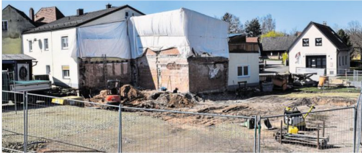
Auch ohne offiziellen Spatenstich geht es endlich voran beim Bau des neuen Feuerwehrhauses in Dießfurt.
